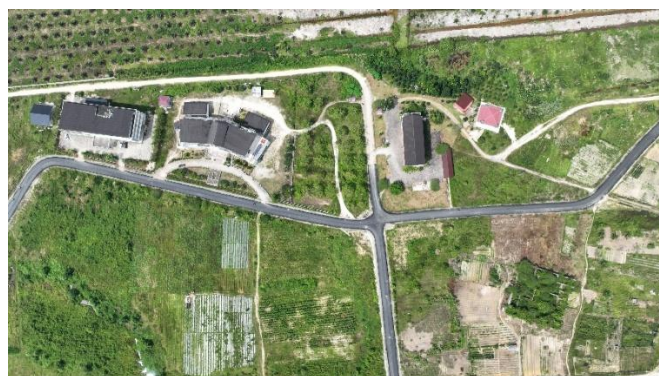
Gambar 1. 13 Akses Jalan ke Gerbang Kedua yang telah Selesai Dikerjakan
